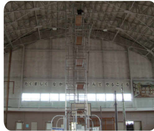
■ 専用の足場を利用したの高所点検
