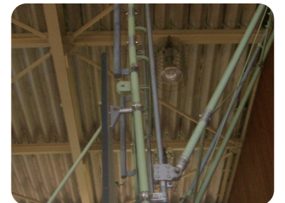
吊り下げバスケットゴールフレームの変形
