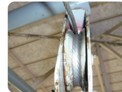
吊り下げバスケットゴール直上車の摩耗
