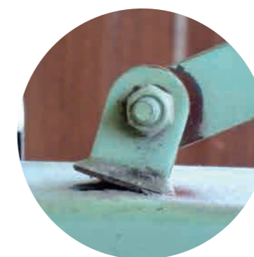
折り畳みバスケット溶接部劣化
