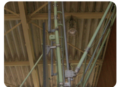
吊下げバスケットゴールフレームの変形
