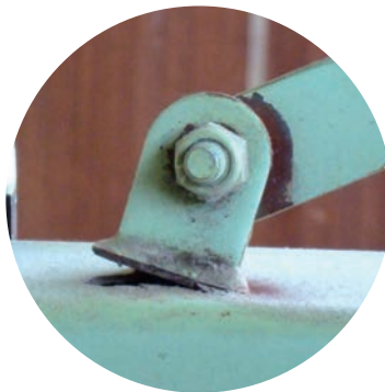
折り畳みバスケット溶接部劣化
