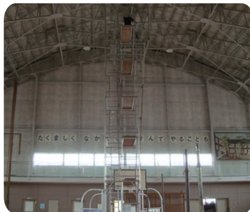
■ 専用の足場を利用しての高所点検
